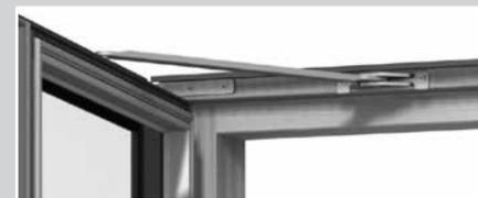
► **Friktionsbremsen** kan fastholde det åbne vindue i vilkårlig ventilationsstilling ved normale vejrforhold. Hvis det blæser meget, skal du dog bruge ventilationsstillingen, der er indbygget i grebet (se s. 28). Friktionsbremsen, der kan sidde både foroven og forneden, er justeret fra fabrikken, så den passer til vinduets størrelse. Synes du, at vinduet går for stramt eller for løst, kan du justere friktionsbremsen (se under den aktuelle vinduestype s. 12-24).
